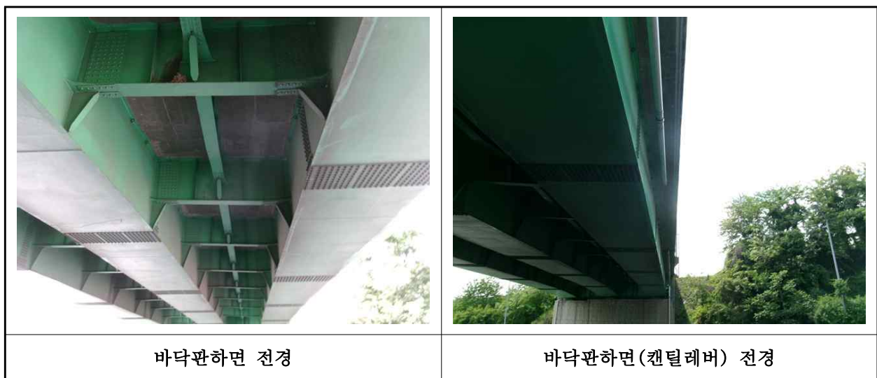
【사진 1.3.2】 바닥판하면 전경
