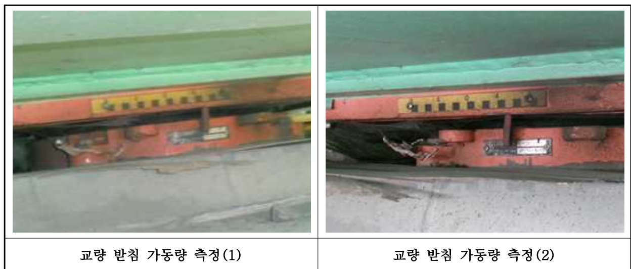
【사진 1.3.13】교량받침 이동량 측정
