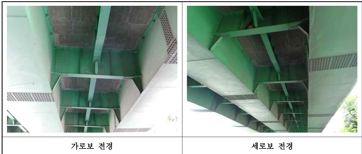
【사진 1.3.6】 가로보 및 세로보 전경
