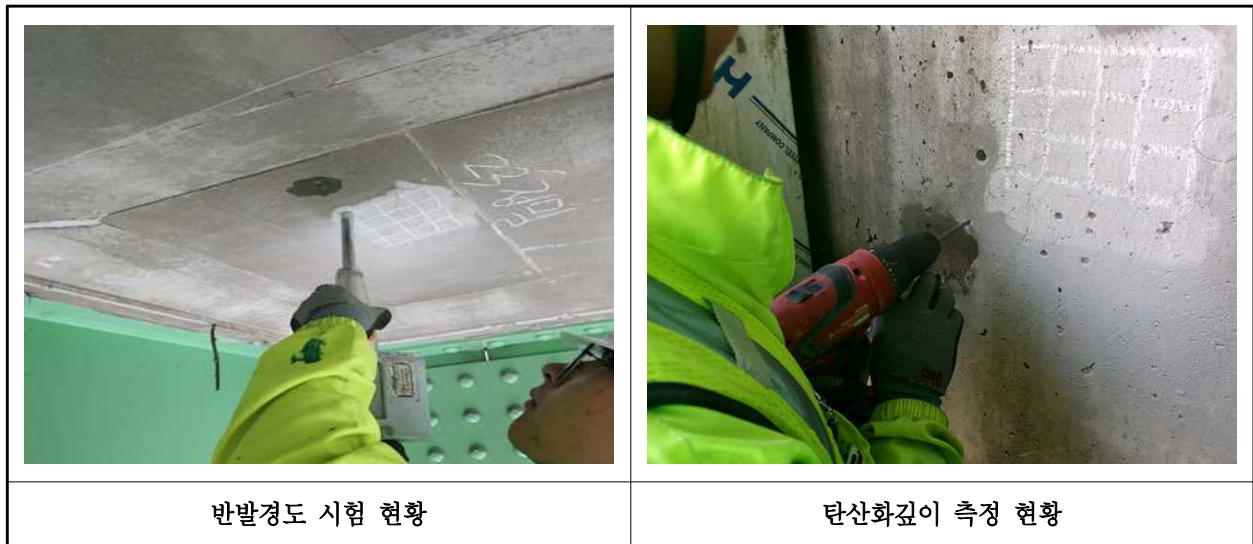
【사진 1.4.1】 콘크리트 내구성조사 현황
