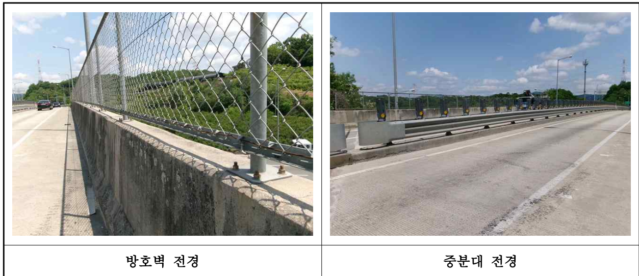
【사진 1.3.21】 방호벽 및 중앙분리대 전경
