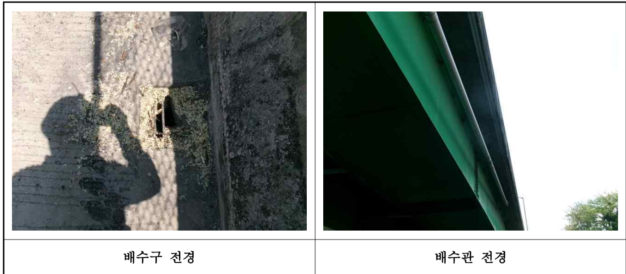
【사진 1.3.19】 배수시설 전경
