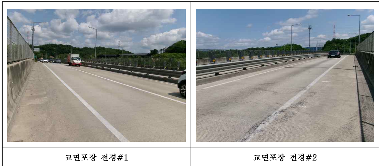
【사진 1.3.17】 교면포장 전경
