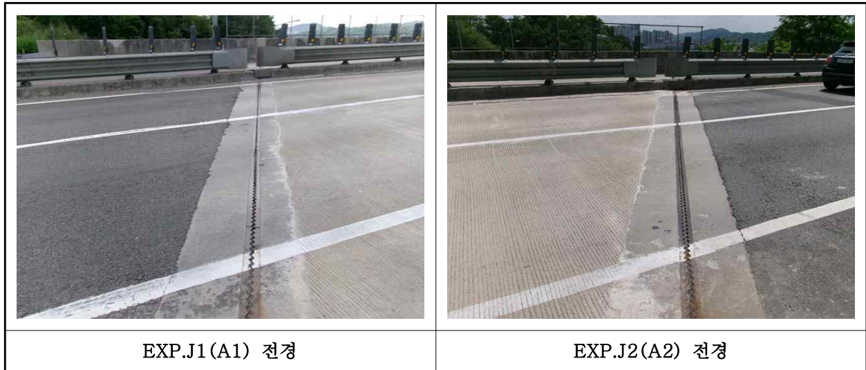
【사진 1.3.14】 신축이음장치 전경
