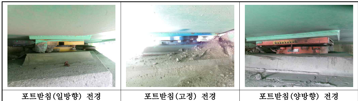
【사진 1.3.10】 교량받침 전경
